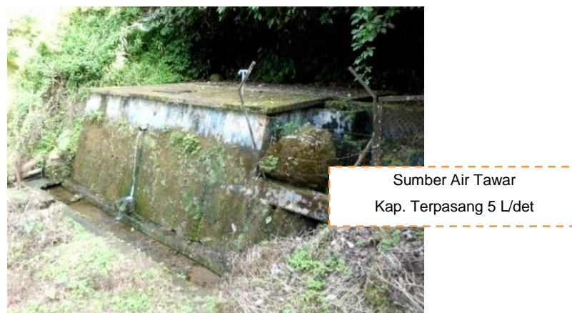
Gambar III.19 Unit Produksi pada Sumber Air Tawar (Tandikat)
