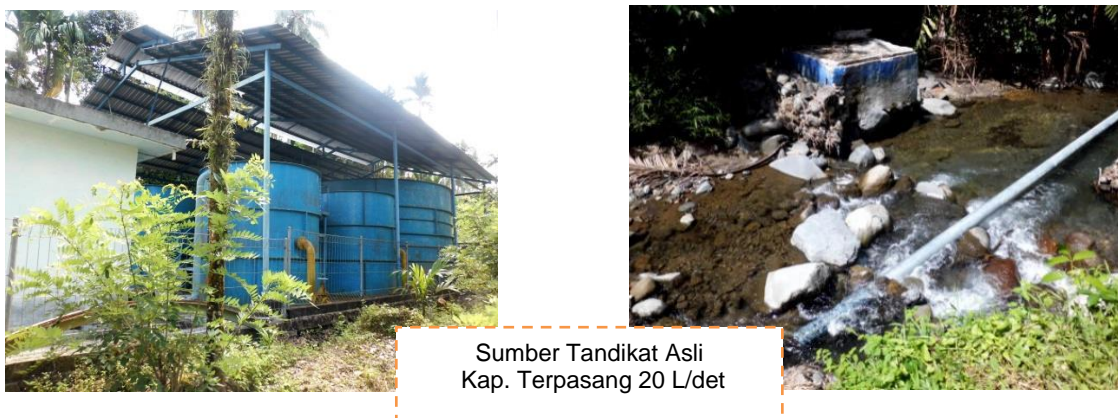
Gambar III.27 Unit Produksi pada Sumber Tandikat Asli
