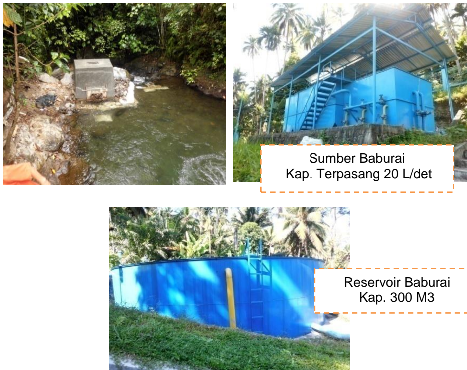
Gambar III. 34 Unit Produksi pada Sumber Baburai
