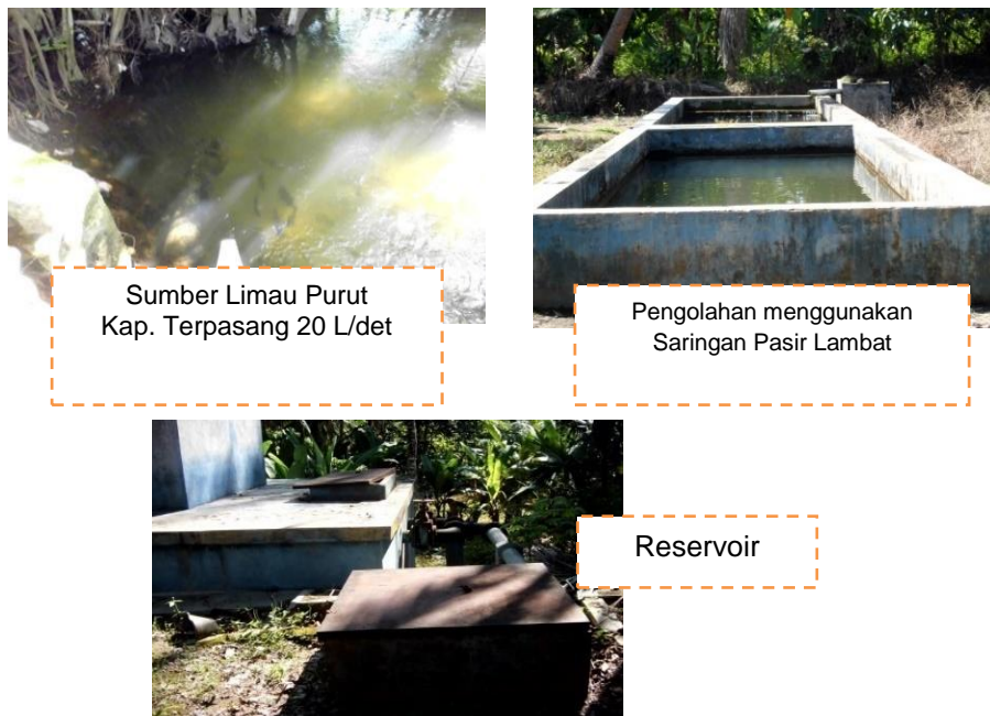
Gambar III.21 Unit Produksi pada Sumber Limau Purut
