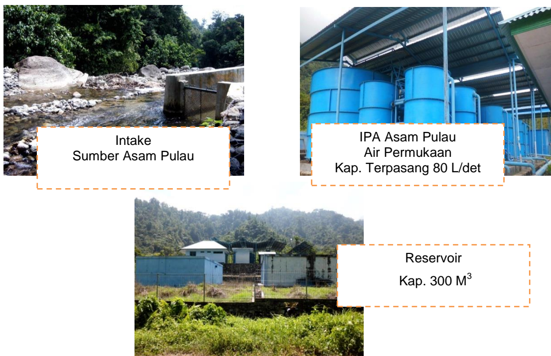
Gambar III.10 Unit Produksi pada Sumber Asam Pulau
