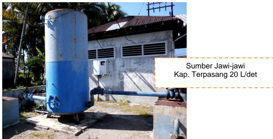
Gambar III.19 Unit Produksi pada Sumber Jawi-Jawi
