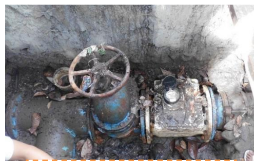
Meteran Induk Unit Pauh Kamar Supply Air dari Bronc Andaleh dan Bronc Lubuk Bonta
